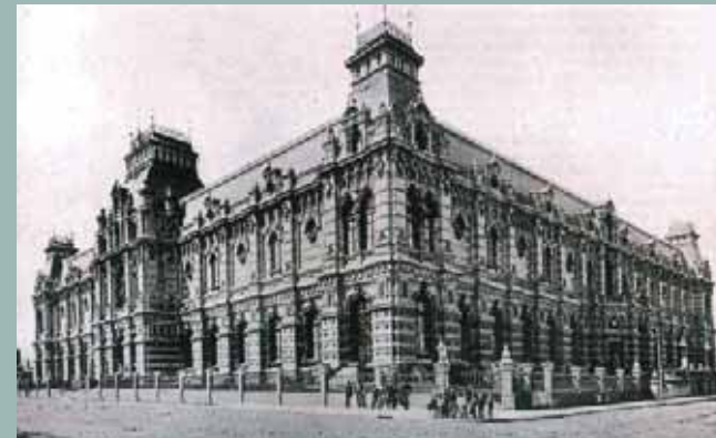
Palacio de las Aguas Corrientes, 1900.
